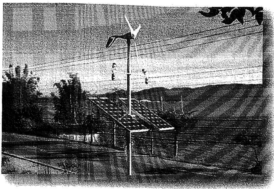
Figura 3 - Sistema híbrido eólico fotovoltaico
